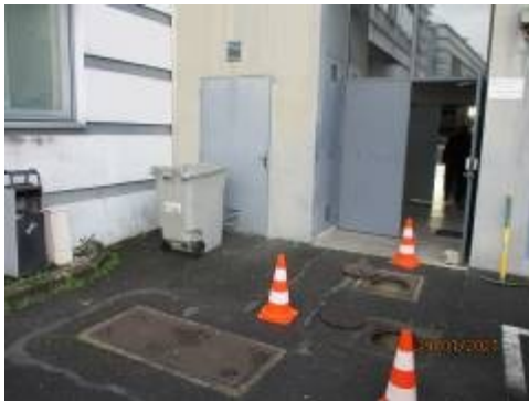
Emplacement regard eaux usées n°1 (droite)
