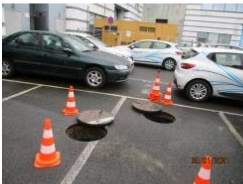
Emplacement regard eaux usées n°2 (à gauche)
