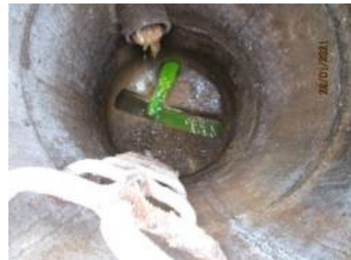
Intérieur regard eaux usées n°2
