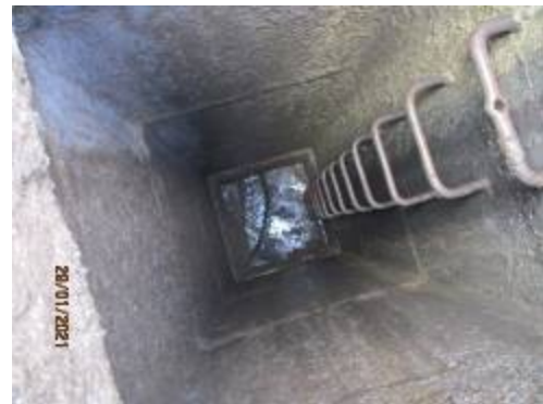
Intérieur réseau d'eaux usées
