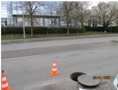
Emplacement réseau d'eaux usées
