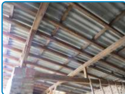
D.O. n° 3 sur Toit Plaques fibre-ciment
