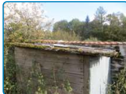
D.O. n° 4 sur Toit Plaques fibre-ciment
